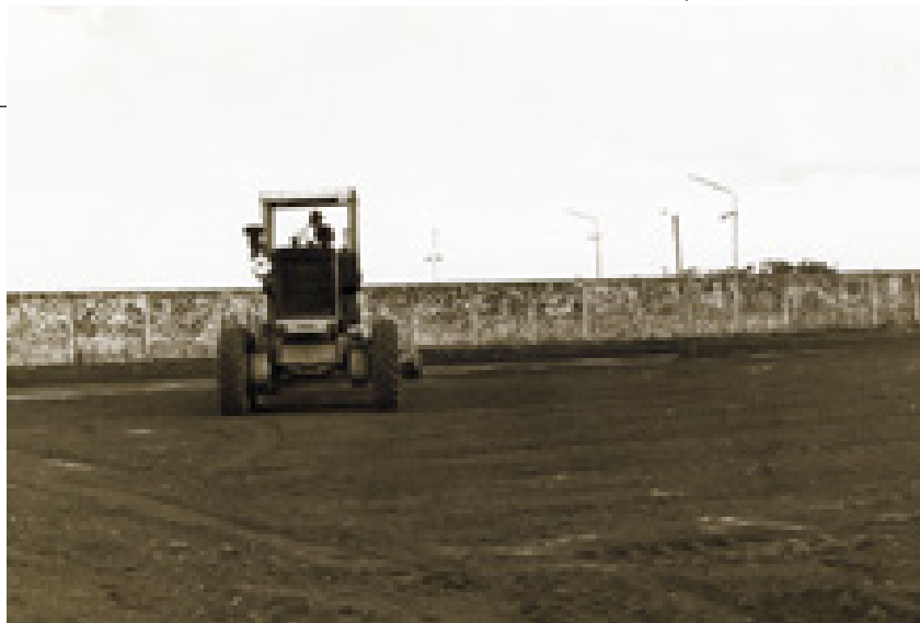
Construção do campo de futebol em 1988
